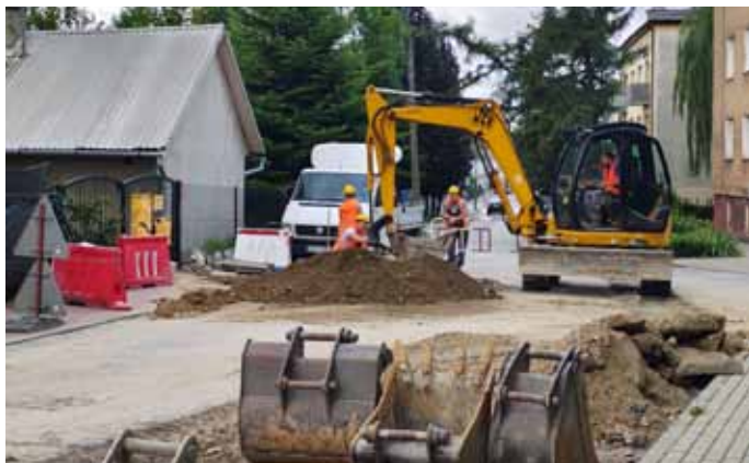
Remont ulicy Ochronek
