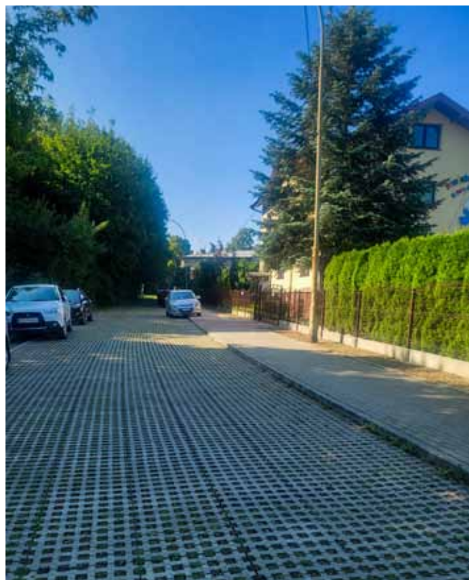
Wyremontowana ulica Osiedle
