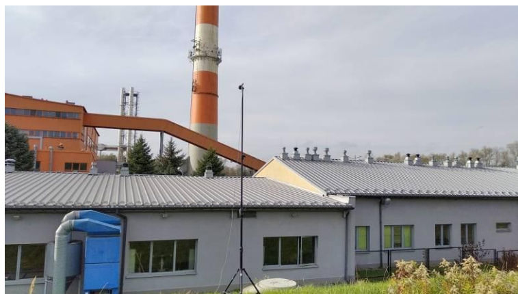
Fot. 1. Fotografie z miejsc wykonywania pomiarów
